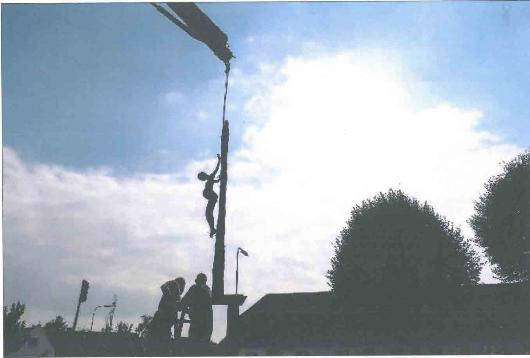
Det vakte opsigt i området omkring museet Holmen i Løgumkloster, da det store Jens Galschiøt-skulpturer blev løftet på plads i og inden i bygningen. Se flere foto fra operationen på www.jv.dk/toender . Foto: Hans Chr. Gabelgaard
